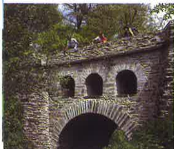
Pont de Graunès
