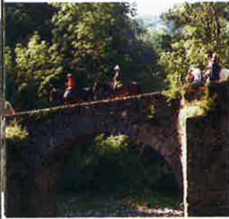
Pont de Comencau
