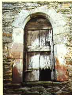
Fenêtre bâtiment mairie
